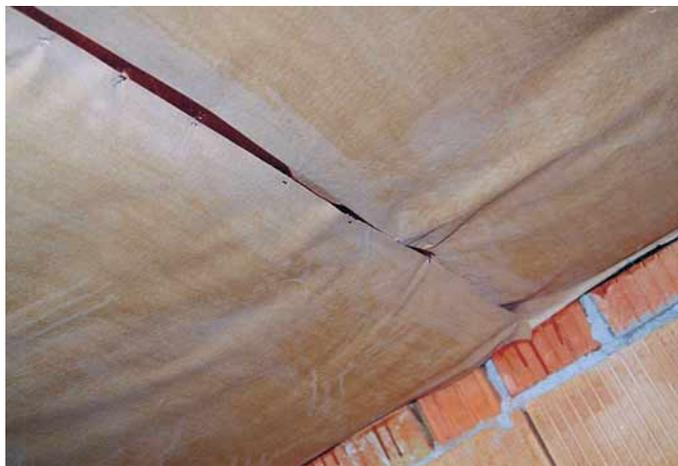
◀ Durch den fehlenden Anschluss der Luftdichtungs-ebene an das Giebelmauerwerk kann warme feuchtigkeitsangereicherte Luft ungehindert in das Bauteil gelangen.
