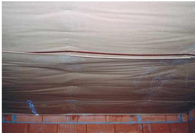
← Oft wird die Funktion der Luftdichtigkeitsebene unterschätzt und gedacht, dass die warme Luft nach oben wandert und die Überlappung nicht verklebt werden muss.
