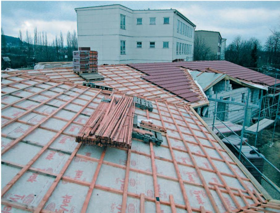
**Als Witterungsschutz eingebaute Unterspann-/Unterdeckbahnen sind nach dreimonatiger Bewitterung keinesfalls mehr neu. Dieser Umstand wird in der EN 13859 entsprechend berücksichtigt.**
