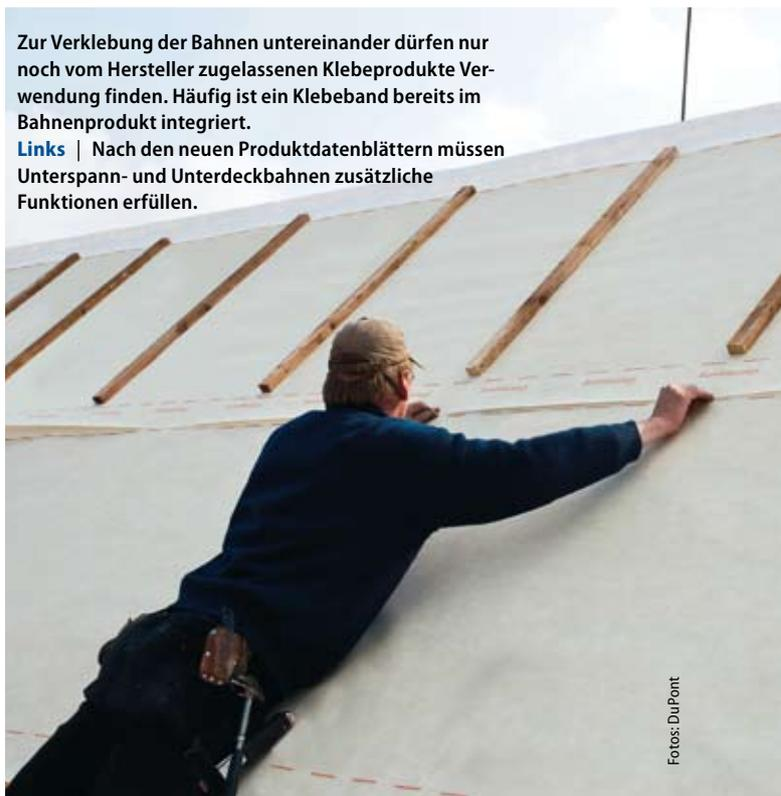
Zur Verklebung der Bahnen untereinander dürfen nur noch vom Hersteller zugelassenen Klebprodukte Verwendung finden. Häufig ist ein Klebeband bereits im Bahnenprodukt integriert.
