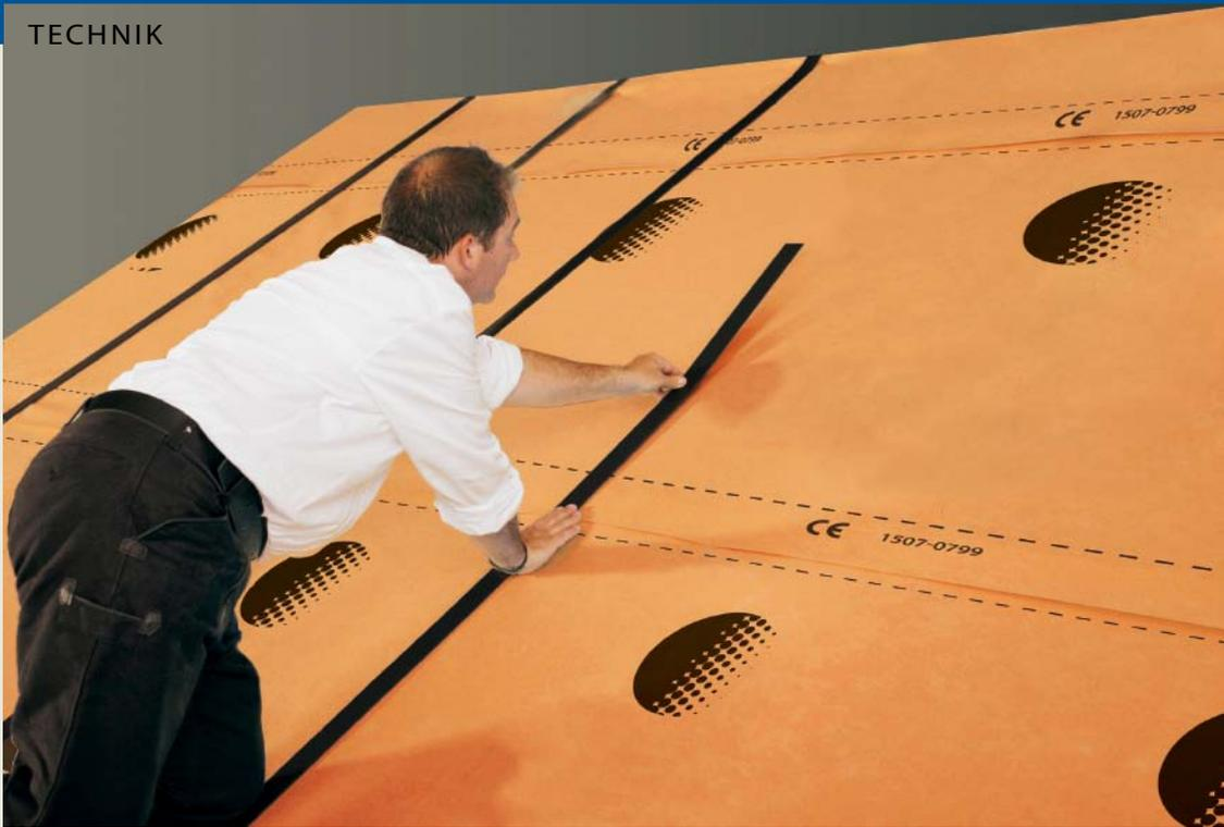
Das Verkleben von Nageldichtbändern unter der Konterlatte – eine übliche Zusatzmaßnahme der Klasse 3 für bewohnte Dächer mit mehreren erhöhten Anforderungen.
